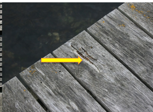
Robinia med spricka och konstaterat angrepp av soft rot röta
