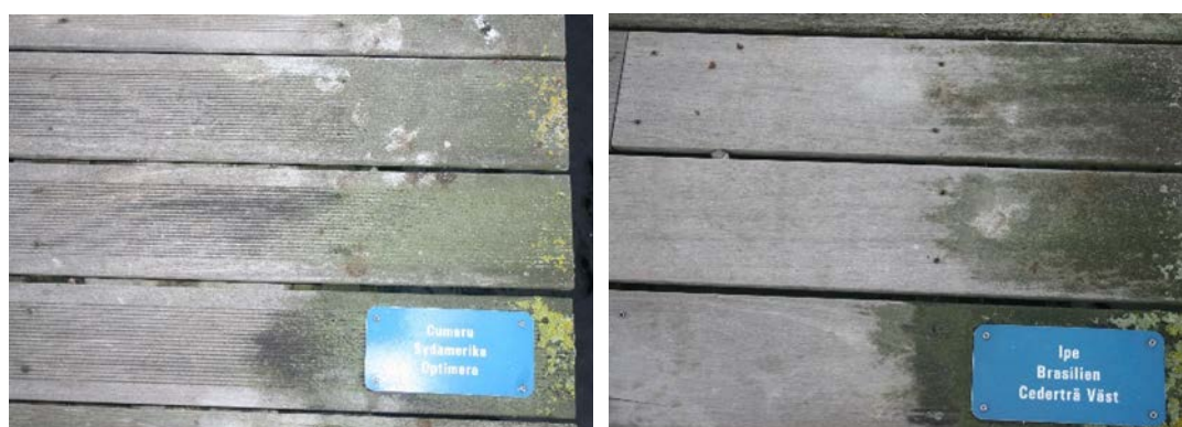
Figur 17. Utseende hos cumaru och ipé i brygga J vid senaste inspektionstillfället. Referensbitar för färgjämförelse saknas.
