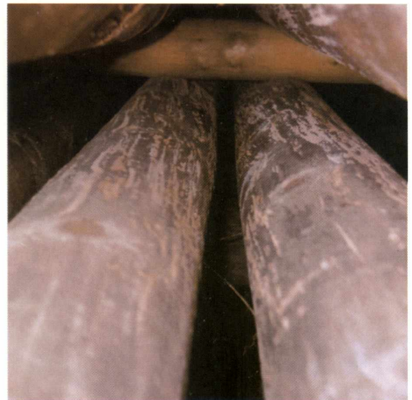
Figur 33. Observerte skader på stolper som er tørket i friluft Figure 33. Poles dried in pole yards attacked by blue stain and decay
