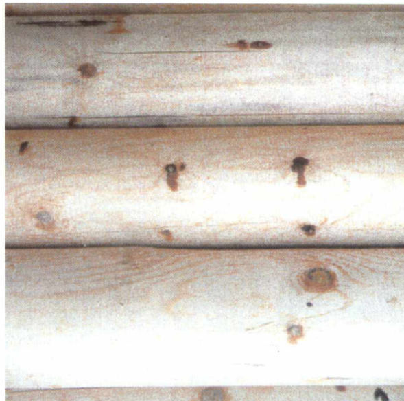
Figur 27. Kvaeflyting og overflatesprekk i stolper tørket i luft ved 80°C
