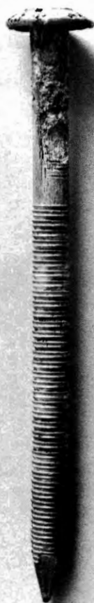
Bild 3. Gropfrätning på aluminiumspik. Pitting corrosion of an aluminium nail.
