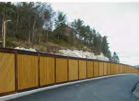
Bullerskärm i tryckimpregnerat trä efter infärgning med en linoljebaserad produkt.
