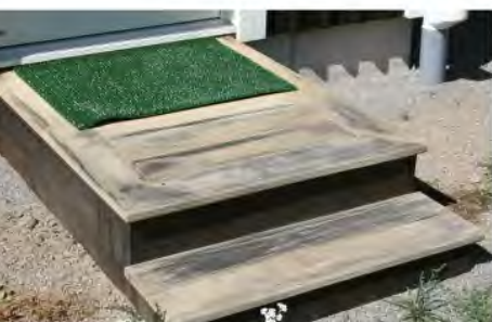
Acetylerat trä ger inget skydd mot påväxt av missfärgande svampar.
