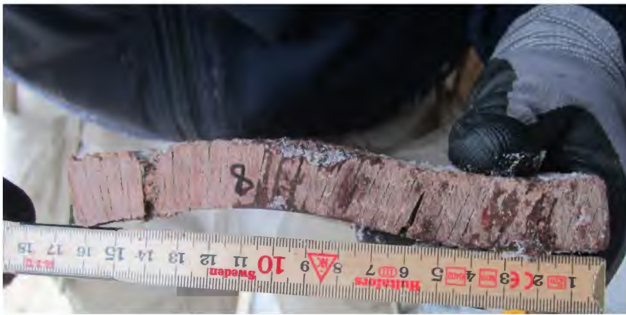
Altanbräda av det tropiska träslaget massaranduba som efter inmontering svällt kraftigt.
