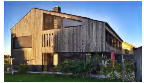
Fasader är ett typiskt användningsområde för värmebehandlat trä.
