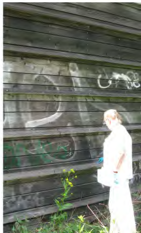
Det är inte alltid lärken åldras som man tänkt sig (se ovan). Bilden till höger visar en bullerskärm av lärk efter tio år, uppsatt längs järnvägen norr om Stockholm mot Uppsala. Skärmen har blivit alldeles svart. Inte helt ovanligt att det blir så istället för silvergrått.
