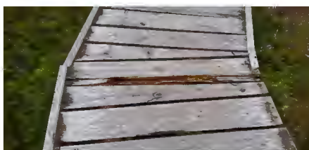
Spång av furukärnved med inslag av splintved, som relativt snabbt angripits av röta. FOTO: STIG BARDAGE, RISE
