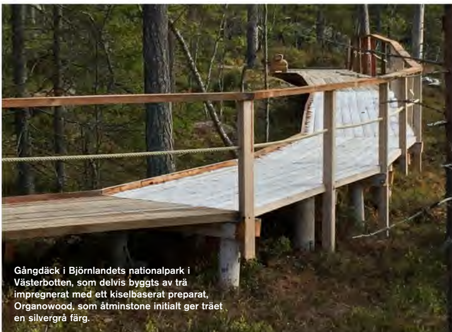
En hel del reklamationer har drabbat trä behandlat med kiselpreparat, då man i vissa fall fått kraftig fiberlossning.
