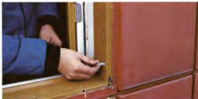
Fig 36. Röttskadat fönster som behandlas genom s k depåimpregnering. Gjutna stavar av en borförening placeras i förborrade hål i virket närmast röttskadan. Fukten i träet löser successivt upp staven, borföreningen sprider sig i virket och vidare rötangrepp förhindras. Foto: Jöran Jermer.
