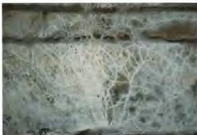
Fig 7. Hussvampsmycel med tydligt utbildade mycelsträngar som växer på en tegelvägg. Foto: John Thornton.
