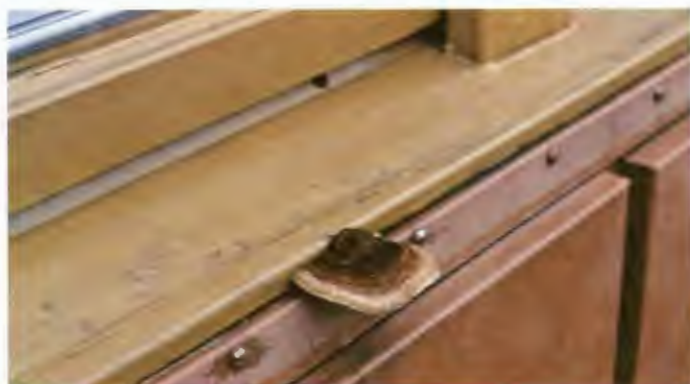
Fig 16. Väl utvecklad fruktkropp av vedmusslingen ( Gloeophyllum sepiarium ) på karmbottenstycke. Vedmusslingen är den vanligast förekommande rötsvampen i fönsterkonstruktioner. Den trivs på virke som omväxlande utsätts för sol och nederbörd, och den nöjer sig med relativt låg fuktkvot (ca 40 %) i virket. Det i virket växande mycelet har stor förmåga att överleva värme och torka. Foto: Paul-Erik Dickèr, Prolignum AB.
