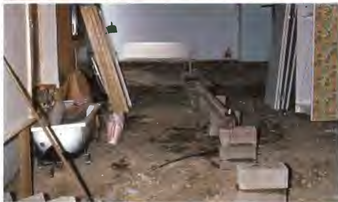
Fig 33 a och b. Omfattande reparationsarbeten krävs ofta för att en sanering skall lyckas. I fallet ovan var man, utöver förbättringar av ventilationen i grunden och tätning av ett läckage vid grundmuren, tvungen att riva ut det rötskadade golvet och ersätta det med nytt. Foto: Leif Zaar. Terminator AB.
