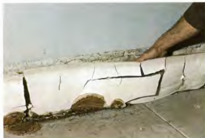
Fig 19. Fruktkropp av hussvampen som tränger fram under en sockel. Foto: John Thornton.
