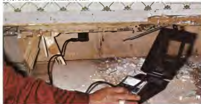
Fig 34. Fuktkvoten i virket skall inte överstiga 20 %, vilket kan kontrolleras med en elektrisk fuktkvotsmätare. Foto: Leif Zaar.
